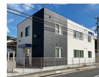
隠岐営業所(新築) 竣工:2025年1月 基準:『ZEB』 延床面積:285.24㎡(地上2階) 太陽光設備:14.94 kW
