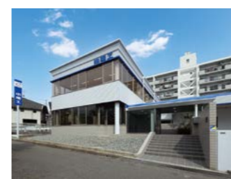
呉営業所(改修) 竣工:2024年5月 基準:Nearly ZEB 延床面積:1099.9㎡(地上2階) 太陽光設備:20.40 kW
