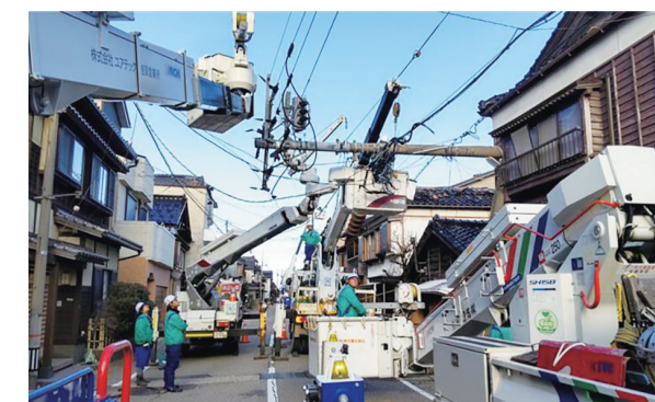
令和6年能登半島地震復旧作業(石川県)
