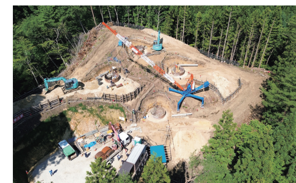
宮城丸森幹線 鉄塔基礎工事(宮城県)
