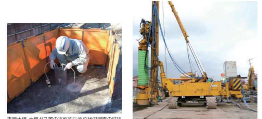
表層土壌、土壌ガス等の平面的な汚染状況調査の結果をもとに、深さ方向の汚染状況を調査します。
