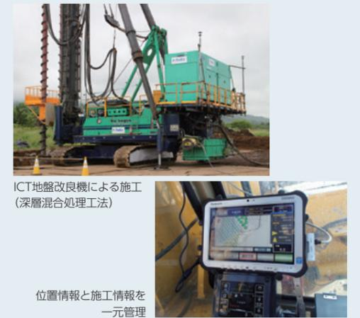
ICT地盤改良機による施工（深層混合処理工法）
