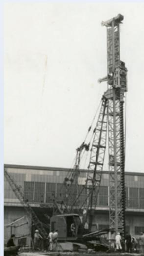
地盤改良工法であるRG/パイル工法
