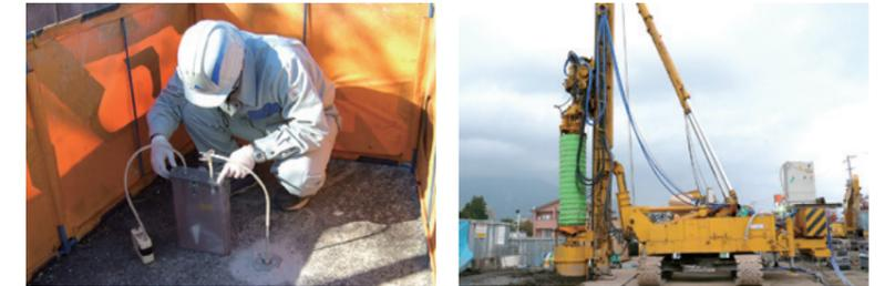
表層土壌、土壌ガス等の平面的な汚染状況調査の結果をもとに、深さ方向の汚染状況を調査します。 浄化対策技術
