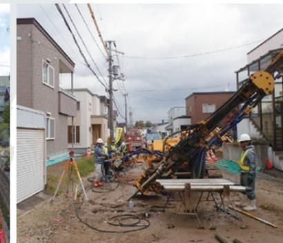
浸透固化処理工法で住宅下部を地盤改良
