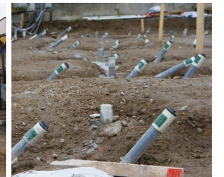
薬液を浸透注入し建物の変位・変形を最小限に抑える
