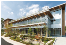
筑波研究所 新研究棟
