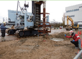
杭孔処理施工試験
