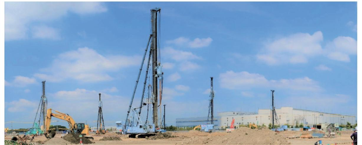
施工機6台を投入した現場「トーンサービスTLP群馬」でのテノコラム工法施工の様相（2020年8月）
