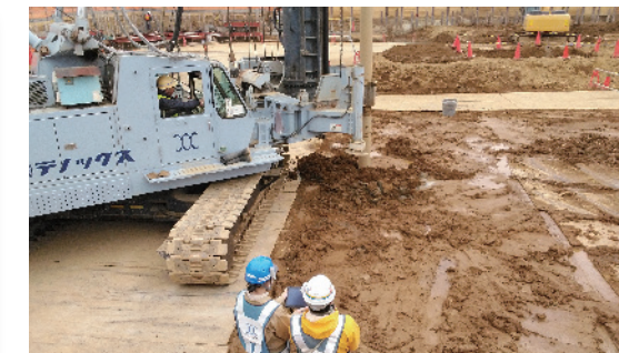
テノコラム工法での工事立会の様子(左:本人)
