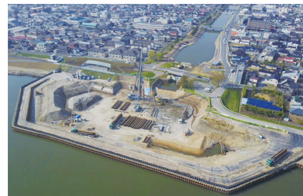
旧北上川石井水門設置工事(宮城県石巻市 平成29年5月撮影)
