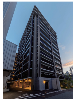
グランピアニースカイ前マンション建替組合 様 （仮称）グランピアニースカイ前マンション建替計画新築工事（熊本県）
