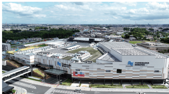
株式会社相鉄アーバンクリエイツ 様 （仮称）ゆめが丘大規模集客施設新築工事（神奈川県）
