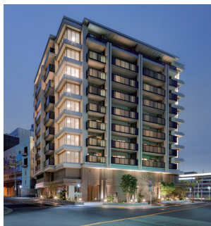
株式会社日本エスコン 様 （仮称）箕面市船場東計画新築工事（大阪府）
