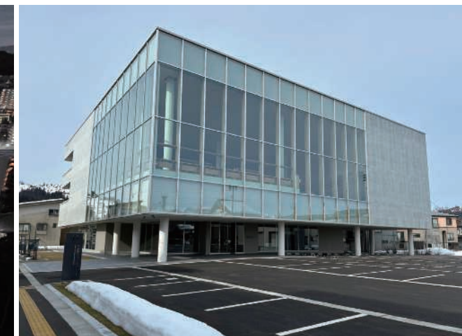
魚沼市生涯学習センター建築工事(新潟県)
