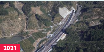
2021 柳瀬トンネル（和歌山県）
