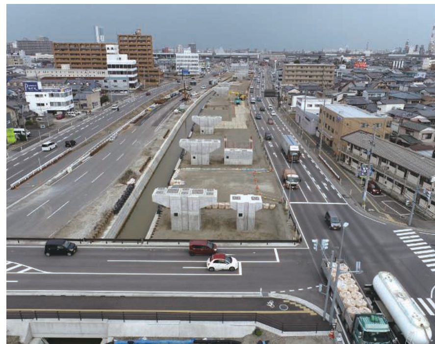
栗ノ木道路 栗ノ木高架橋下部(下り・P18-20、ONA2-P2)工事(新潟県)
