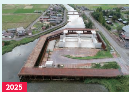
2025 福島漏水門本体（新潟県）
