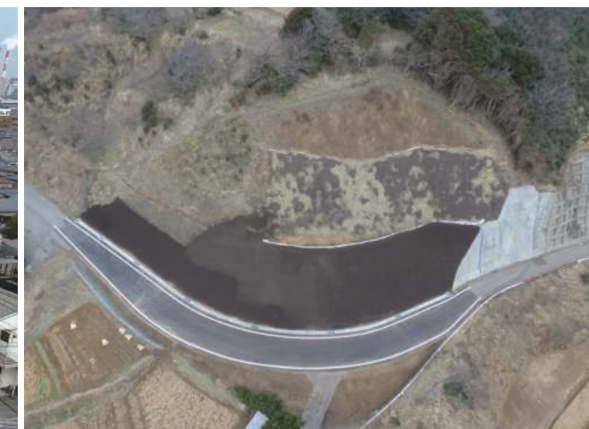
一級市町村道26号線防大雪災害(離島市町村代行)道路改良工事(新潟県)
