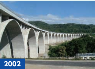
2002 上田ローマン橋（長野県）
