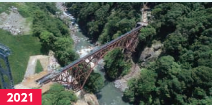
2021 第一白川橋りょう復旧（熊本県）
