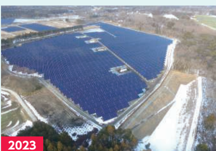
2023 那須メガソーラー（栃木県）
