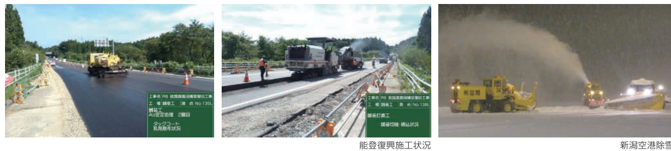
能登復興施工状況
