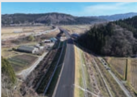
竜毛沢地区改良舗装工事
