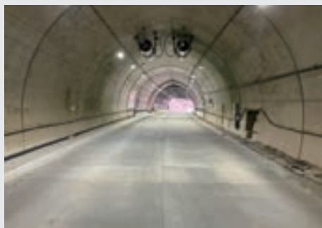
国道289号叶津道路舗装外工事
