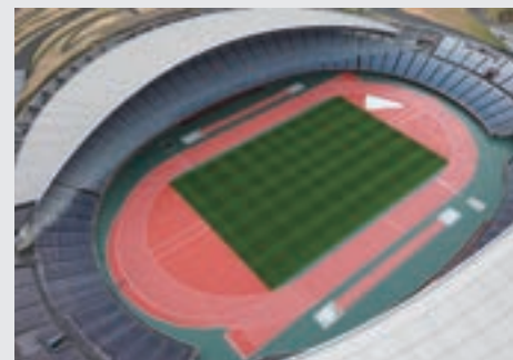
宮城県総合運動公園スタジアム等公認更新整備工事
