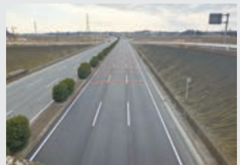
R5国分寺出張所管内路面補修工事
