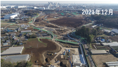
2021年12月 土地の造成・改良工事
