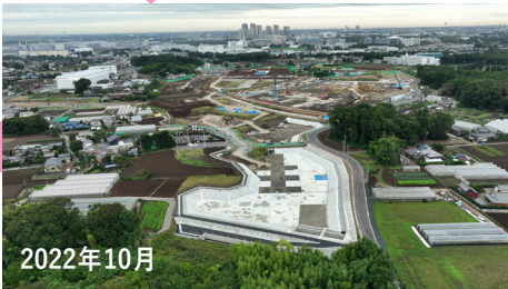
2022年10月 構造物の建設
