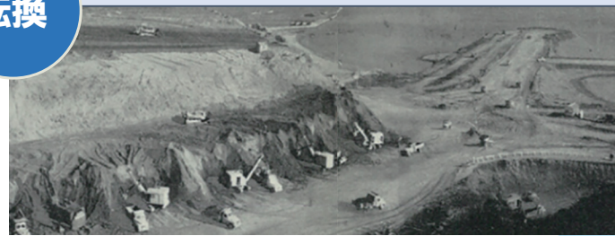
1957年：日本初のリッパ工法を確立（横須賀火力発電所造成工事）
