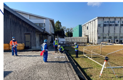
令和 7 年度 6 災 5765 号特定環境保全公共下水道 宇出津処理区災害復旧工事 (管渠) (2 工区) ほか 2 処理区
