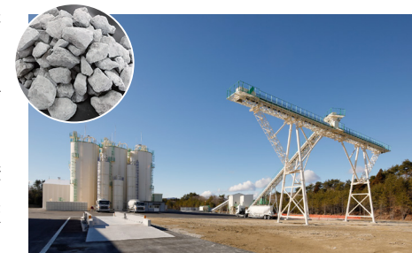
福島エコクリートの人工砕石製造プラント （左上は石炭灰リサイクル砕石）
