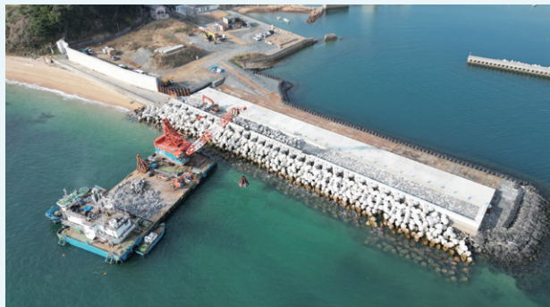
護岸改良工事の状況
