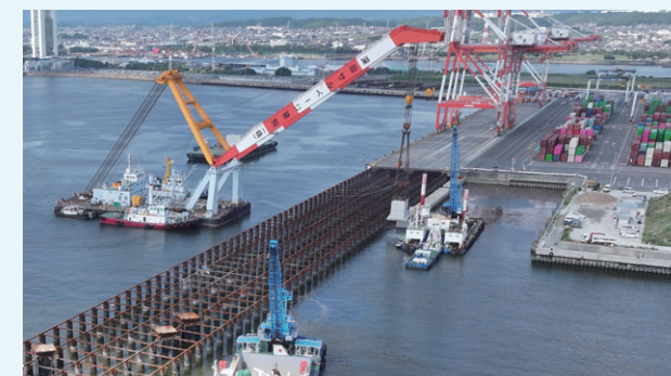
土留（ケーソン）据付け状況
