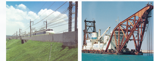
山陽新幹線西厚狭地区工事
