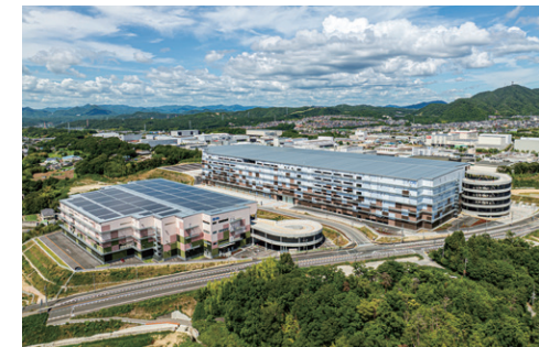
(仮称)CPD西宮北物流施設1新築工事(兵庫県) 発注者 神戸ロジスティクス特定目的会社
