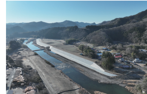
R5久慈川右岸河床北地区整備工事(茨城県) 発注者 国土交通省 関東地方整備局
