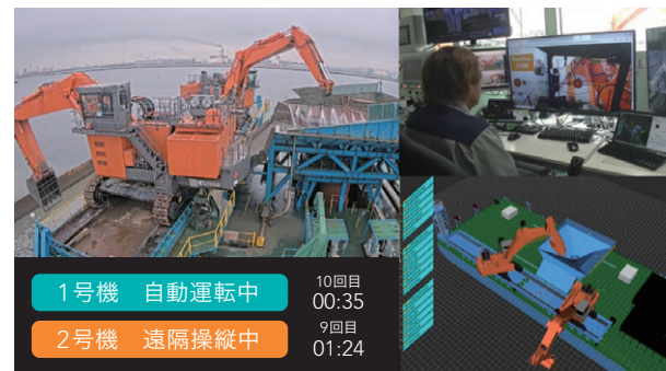
遠隔操縦／自動運転システムによる施工状況
