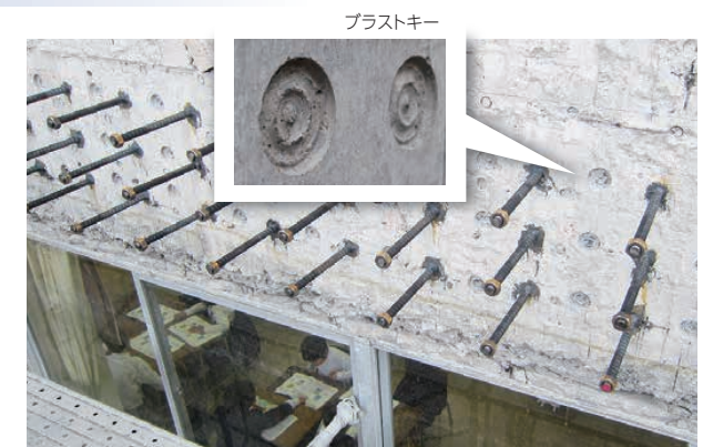
低騒音・低振動であり学校の授業にも支障なく施工が可能です
