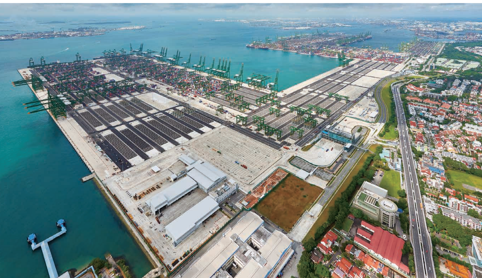
シンガポール パシルパンジャン・ターミナル建設工事（第3期/第4期）
