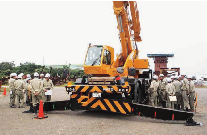
新入社員危険体感教育(クレーンの設置、死角)
