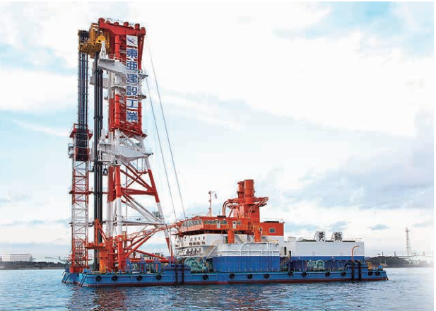
ハイブリッド発電システムを導入した深層混合処理船「黄鶴」(2010年建造)
