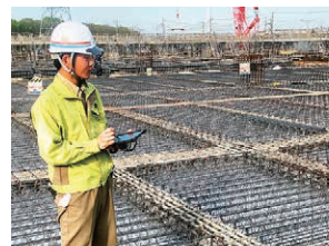
ICTを活用した現場管理
