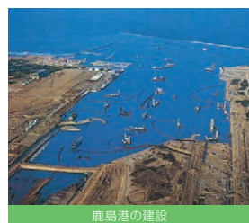
鹿島港の建設
