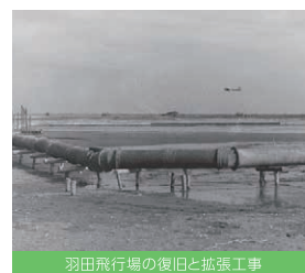
羽田飛行場の復旧と拡張工事
