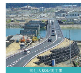
気仙大橋仮橋工事
