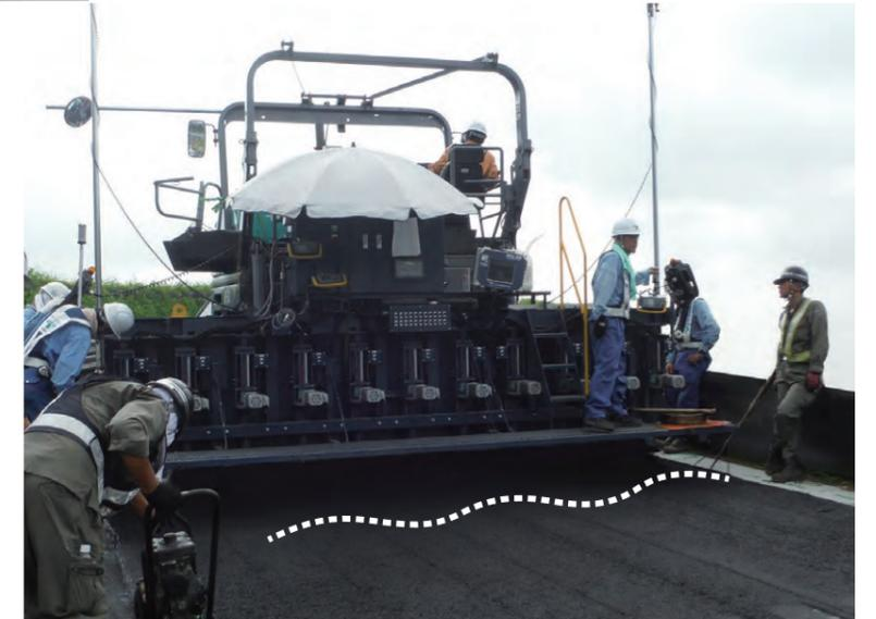
コンピュータ制御されたスクリーンによりアスファルト合材を様々な横断形状に敷き均しすることが可能
