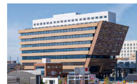
大型複合施設(事務所・ホール等) ウレシヤス小松(石川県) 発注者:北電産業小松ビル合同会社
