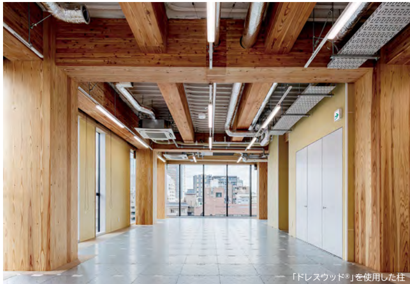
「ドレスウッド®」を使用した柱
