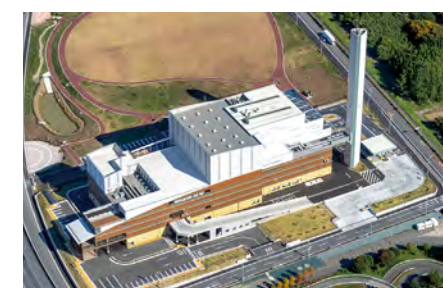
プラント市場 あつあいクリーンセンター(神奈川県) 発注者:厚木愛甲環境施設組合
