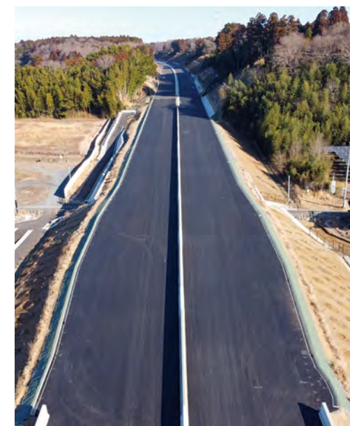
東関東自動車道 塔ヶ崎工事 発注者: 東日本高速道路(株) 関東支社
