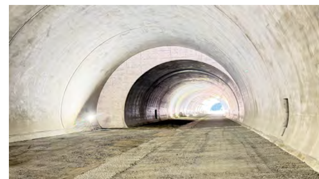
すさみ串本道路江住第一トンネル工事 発注者: 近畿地方整備局
