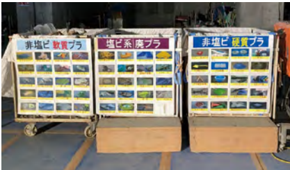
廃プラ分別ヤード
