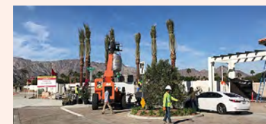
植栽工事施工の様子
