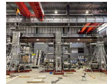
PCaラーメン構造の実大施工実験
