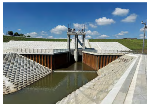
関東地整入間川古谷樋管改築工事
