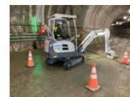
坑口での路盤維持作業
