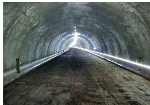
窪川佐賀道路平串トンネル
