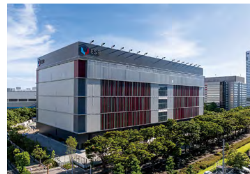
ESR 南港 OS1 データセンター
