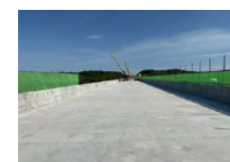
床版取替工事後のママチ川橋
