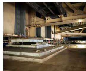
新設支承設置状況
