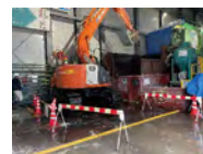
シールド立坑での掘削作業
