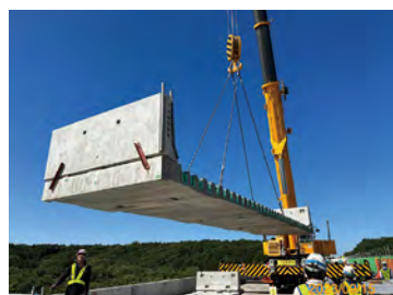
床版と壁高欄の一体架設
