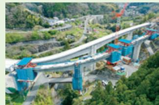
伊豆縦貫自動車道の一部を構成する河津下田道路のうち、河津IC付近に位置するBランプ橋の一部(PC3径間連続ラーメン箱桁橋)を施工しました。伊豆縦貫自動車道は、静岡県沼津市から下田市に至る延長約60kmの自動車専用道路で、伊豆地方のアクセスの向上と安心して生活できる環境の実現などが期待されます。
