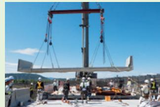
北陸自動車道の福井北IC～丸岡IC間に位置する九頭竜川橋は、橋梁の延命化及び車輛走行時の快適性向上を目的(高速道路リニューアルプロジェクト)として、PC床版への取り替えや橋の部分的な補修を行う工事です。工事による通行への影響を軽減させるため、対面通行により片側ずつ床版を取り替えました。
