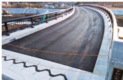
夏井川筋市道橋 (岩手県久慈市)
