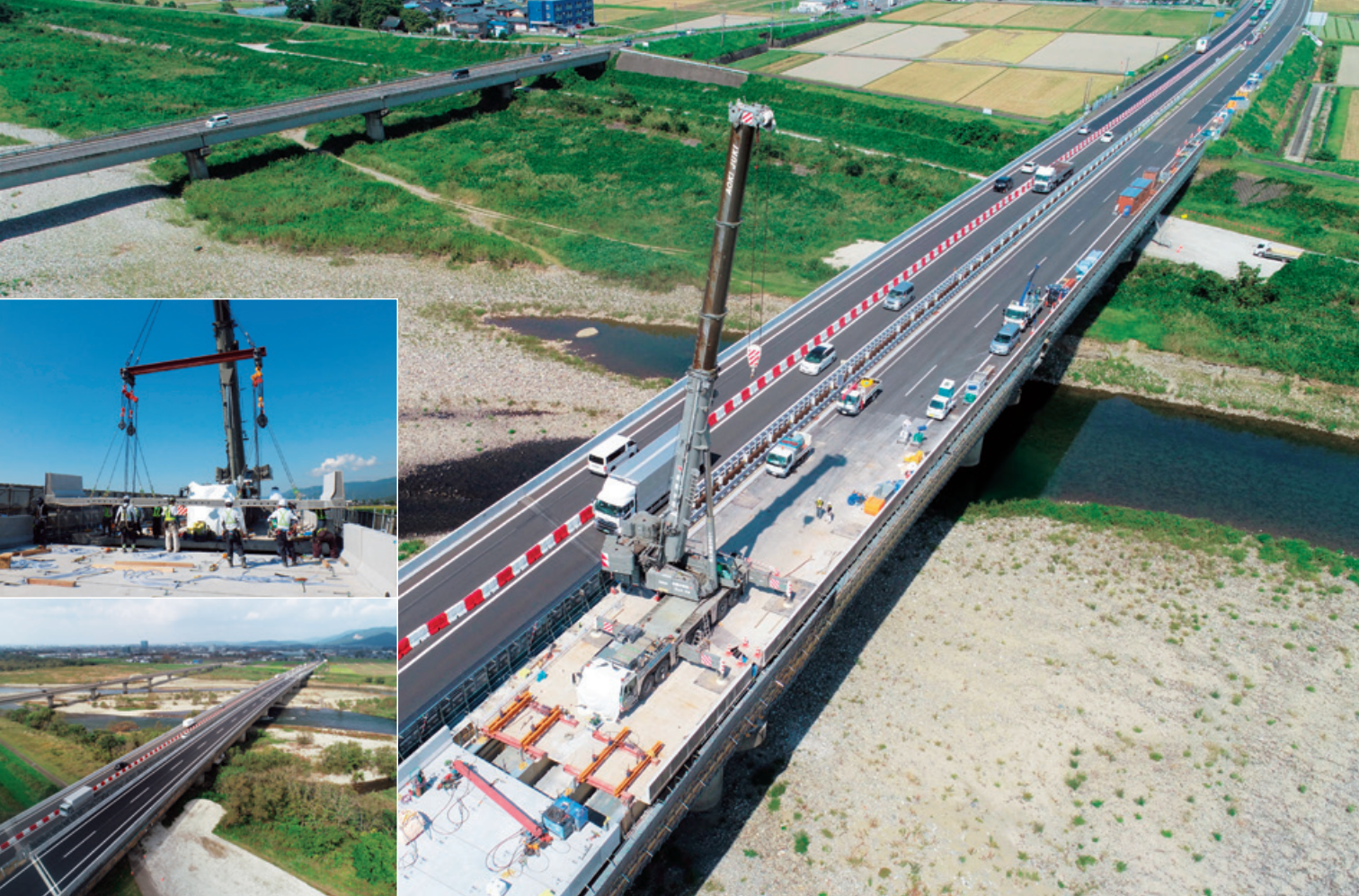
九頭竜川橋床版取替工事 (福井県福井市)
