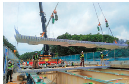
東ノ迫池橋床版取替工事 (広島県庄原市)
