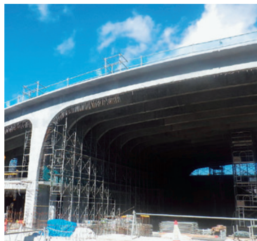
東京未来大学体育館新築工事
