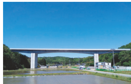
小名浜道路5号橋 (福島県いわき市)
