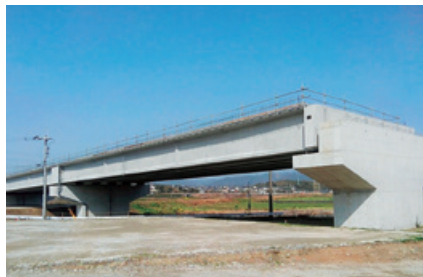
大隈高架橋 (福岡県糟屋郡粕屋町)
