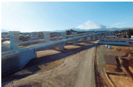
ぐみ沢高架橋OFFランプ (静岡県御殿場市)
