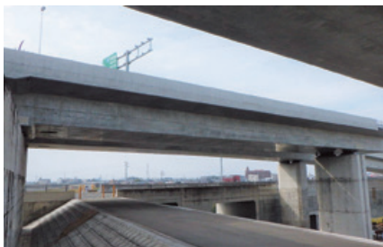
余戸南第1高架橋 (愛媛県松山市)
