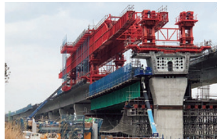
鈴鹿高架橋 (三重県鈴鹿市)
