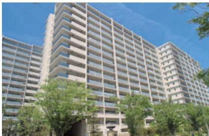
JR塚口駅前新築工事
