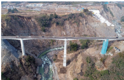
阿蘇長陽大橋外補修工事 (熊本県阿蘇郡)
