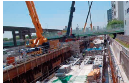
羽田1号線迂回路上部工工事 (東京都品川区)
