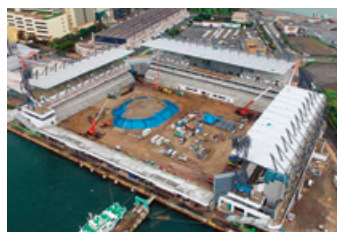
北九州スタジアム建設工事 (福岡県北九州市小倉北区)
