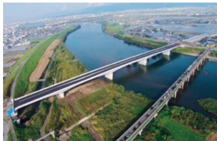
神代橋 (福岡県久留米市)
