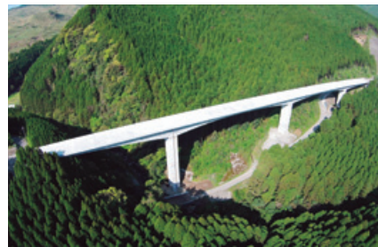
東九州道（清武～北郷）鏡洲川橋上部工工事 (宮崎県宮崎市)
