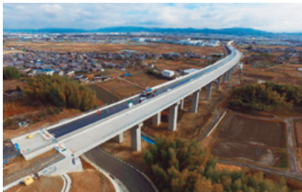
京田辺高架橋 (京都府京田辺市)
