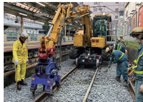
道床つき固め作業
