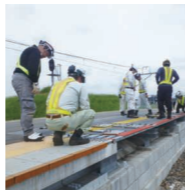
東鉄総合研修センターでのホームドア設置工事研修
