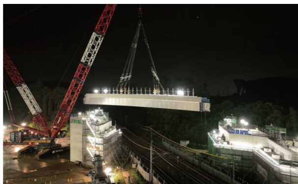
1,350tクレーンによる線路上空の道路橋桁一括架設
