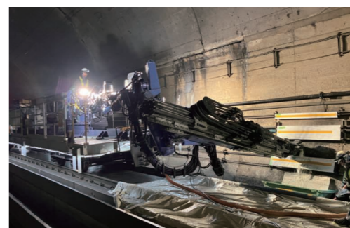
ロックボルト打設（側壁部）
