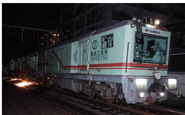
大型保線機械によるレール削正工事
