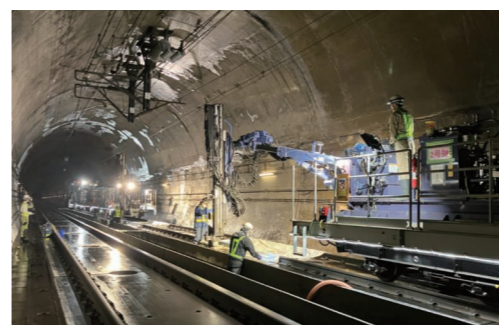
ロックボルト打設（路盤部）
