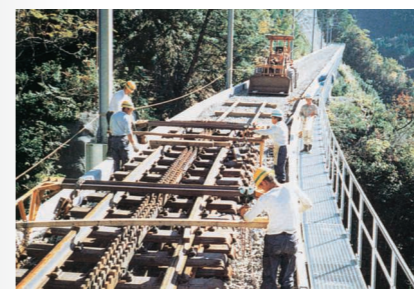
大井川鉄道井川線アプト式軌道敷設 軌道中央のラックと列車の歯車がかみ合って 急坂を安全に上下することができる
