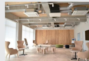
日本が有する豊富な森林の保全と、有効な活用を推進するため、技術研究所の1階部分はRC造とCLT(クロス・ラミネイテッド・ティンバー)耐震壁、天井は配筋付製材型枠を仕上げ材として使用、2階は木質ラーメン構造を採用しています。当社初のRCと木質のハイブリッド構造となっています。
