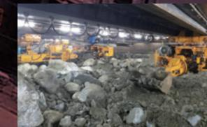
函内掘削状況(無人掘削)
