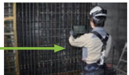
TOFカメラ搭載タブレットでの計測作業
