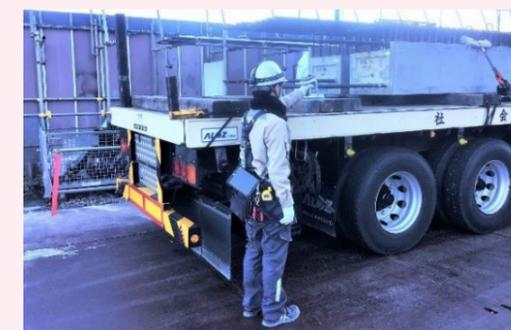
現場納入時にRFIDタグを読み取る様子
