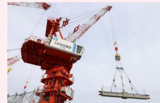
運転システムと吊荷回転制御システムを導入したタワークレーン
