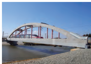
秋田新幹線齊内川橋りょう改築（秋田県）
