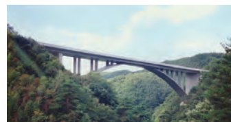
1992 中国横断自動車道 俣野川橋PC上部工
