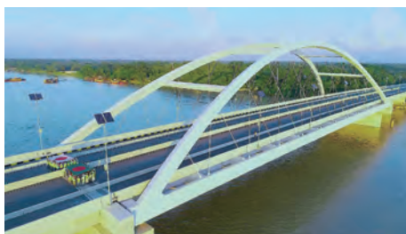
クロスボーダー道路網整備事業 パッケージA1 モドゥモティ橋（バングラデシュ）
