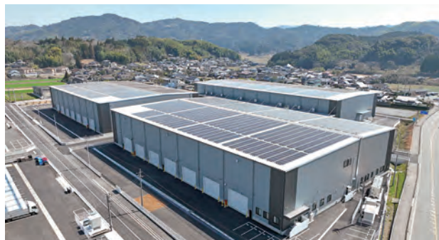
御船町木倉物流倉庫新築工事【C1棟・C2棟・D棟】
