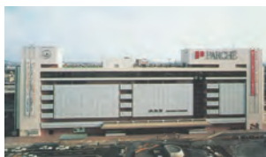
1982 静岡ターミナルビル
