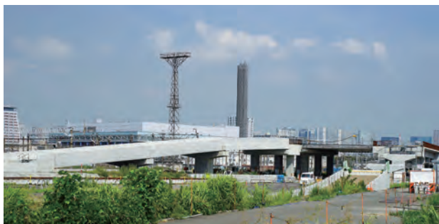
羽田空港アクセス線八潮区建設
