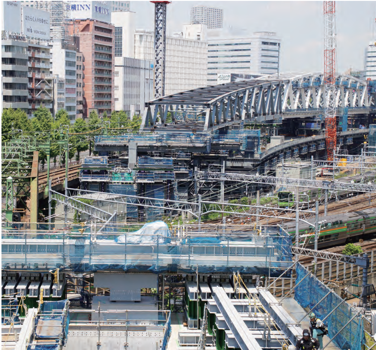
JR線を跨ぐ京急本線品川・北品川間ハツ山橋りょう架替
