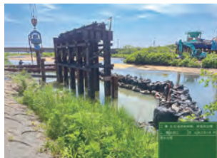
土嚢による濁水拡散防止
