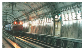
1986 青函トンネル・電飛工区
