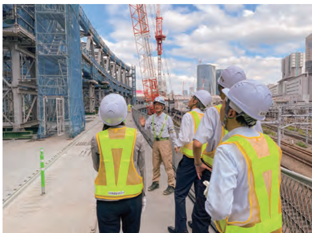
監査役による現場視察（ハツ山橋りょう）
