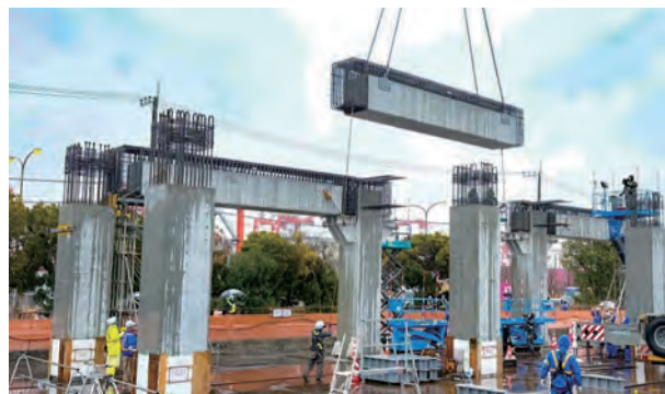
東京貨物ターミナル改良工事でのプレキャスト部材の試験施工の様子 JR東日本撮影協力
