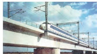
1971 山陽新幹線加古川橋梁
