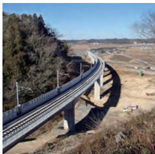
2013 東日本大震災復旧 JR仙石線野蒜工区
