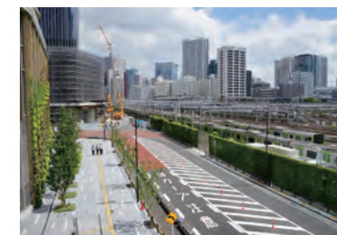
高輪ゲートウェイ駅周辺街路等の整備
