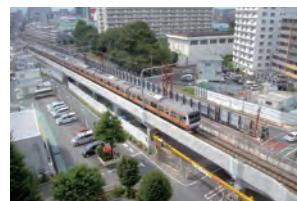
2009 中央線連続立体交差化事業 立川駅付近高架橋
