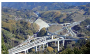
2019 中部横断自動車道 新清水ジャンクション
