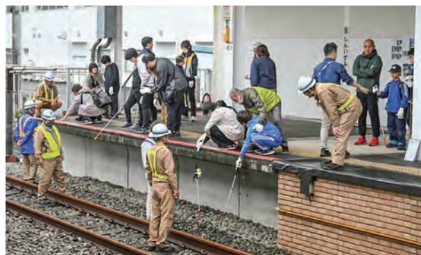
ホームの高さを確認
