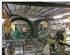
(施工例) ホームに設けた架台を下降させ、線路下(地下階)へ鉄筋を搬入 JR東日本撮影協力
