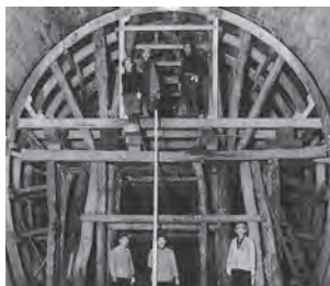
1951 信濃川水力発電所第3期隧道
