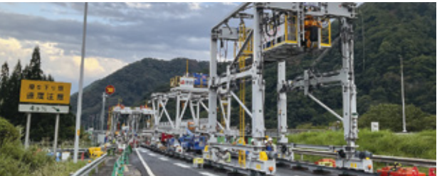
関越自動車道阿能川橋床版取替工事 (群馬県～新潟県)において、床版取替にかかる期間を約67%短縮
