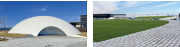
「CUCO®-SUICOMドーム (サステナドーム)」が完成 ※3 NEDO (国立研究開発法人新エネルギー・産業技術総合開発機構) の委託業務 (JPNP21023) を受けた「CO 2 を用いたコンクリート等製造技術開発」の成果を活用
