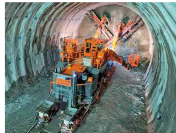
ロックボルト施工の完全機械化(「ロックボルト」使用) 東海北陸自動車道 真木トンネル工事(富山県南砺市)
