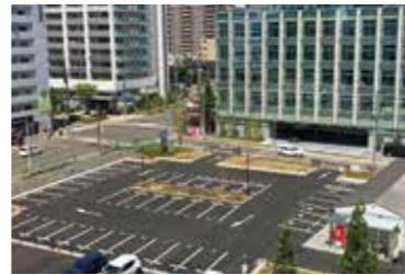
廃ペットボトルを活用した「PETアスコン」 (清水建設東北支店駐車場)
