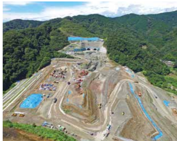
川西工事 塩沢工区全景(大規模盛土工、トンネル工)
