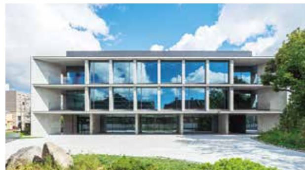
北陸支店新社屋の外観
