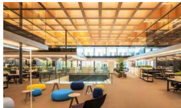
柔らかな自然光を執務空間に供給する屋根架構
