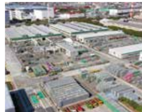
本社機材センター(千葉県船橋市)
