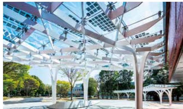
脱炭素社会のシンボルとして本館エントランスに設置された庇 (太陽光パネルを設置、研究が発展・成長する樹木をイメージ)
