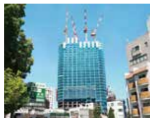
虎ノ門・麻布台地区第一種市街地再開発事業 A街区(東京都港区)で稼働するタワークレーン群
