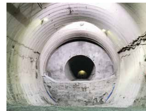
中央導坑先進工法における本坑の断面閉合状況 一般国道40号音威子府村音中トンネル掘削工事(北海道中川郡音威子府村・中川町)
