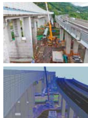
実際の現場(上)、3次元施工シミュレーション(下)
