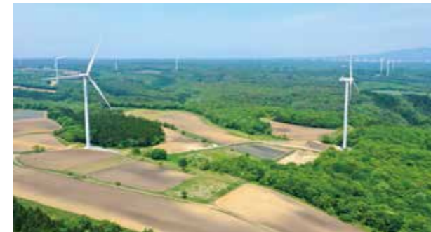
リエネ六ヶ所村千歳風力発電所(青森県六ヶ所村)
