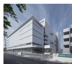
沢井製薬(株) 第二九州工場新棟建設工事
