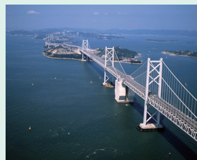
1985 南北備讃瀬戸大橋(下部工、北工区)
