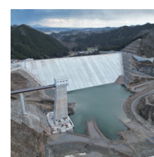
南摩ダム 本体建設工事
