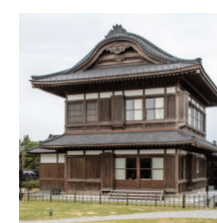
蔵春閣移築工事
