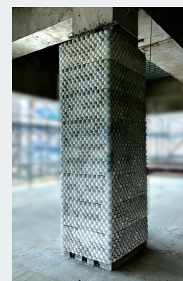
3Dプリンティング技術で製作した柱
