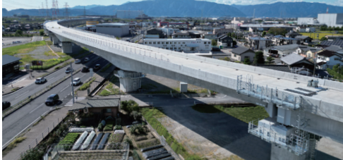
東海環状自動車道 政田第三高架橋他2橋(PC上部工)工事(岐阜県)
