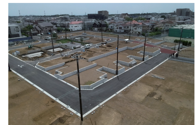
(仮称)豊四季計画宅地造成工事
