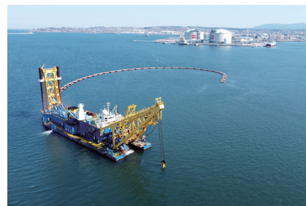
青森県八戸港浚渫工場
