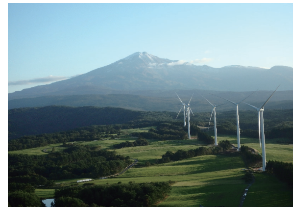
再生可能エネルギー 風力発電事業 青木あすなる建設 (東由利ウインドファーム)
