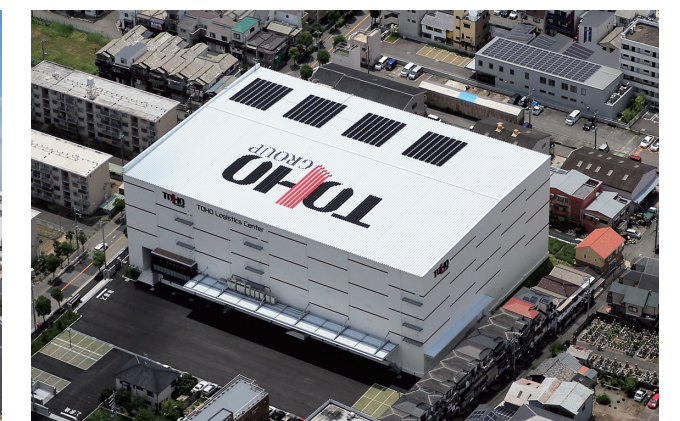
東邦ロジスティクスセンター
