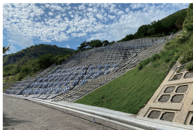
山陽自動車道赤穂地区のり面補強工事
