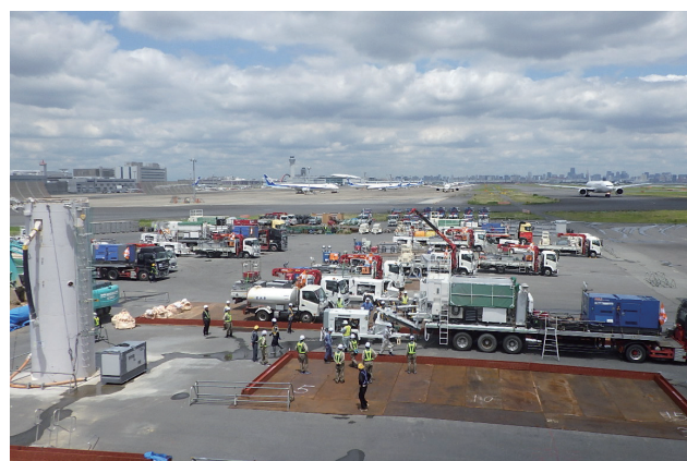
令和5年度東京国際空港A滑走路北側取付誘導路他地盤改良工事
