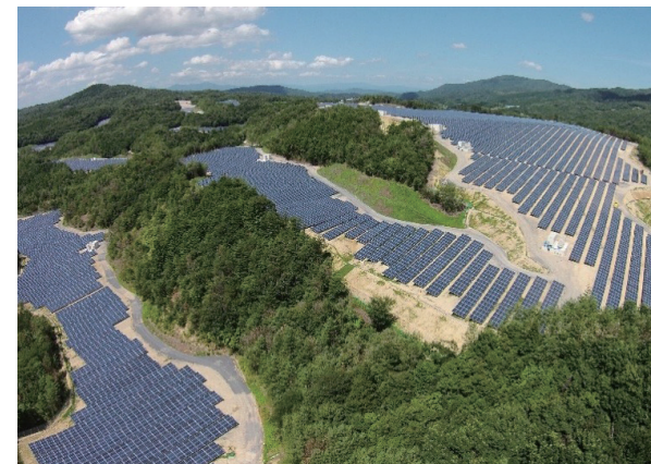
再生可能エネルギー 太陽光発電事業 青木あすなる建設 (久米南メガソーラー)
