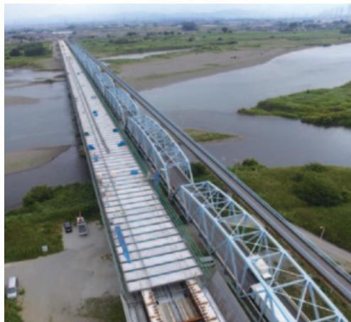
上武大橋は、埼玉県発注の群馬県伊勢崎市と埼玉県深谷市を結び利根川に架かる橋梁です。現橋は、昭和9年に架設された橋梁で老朽化が著しく、幅員が狭いため大型車のすれ違いが困難な状況であり経済面を考慮し橋梁の架け替えが行われました。新しい橋梁は、橋長888m 総幅員12m、13径間連続細幅合成箱桁橋で当社はこの内床版工事を施工いたしました。床版工事は、3工区に分割発注され当社は中央の工区を担当し、施工範囲の大部分が流水域上であり架設はPC版架設機による工法を採用しました。また、増水期間の施工でもっとも条件の悪く、地元・発注者・同業他社・協力業者と良好な関係を築くことで平成29年10月に無事故無災害で工事を完了し発注者から高い評価をいただきました。
