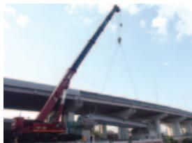
船穂高架橋及び船穂ONランプ高架橋は、岡山県倉敷市における倉敷立体事業の一環として、倉敷市船穂町に架かる橋梁です。倉敷立体事業は、平成19年度から事業を開始し、一般国道2号の倉敷市新田から倉敷市船穂町船穂に至る延長7.7kmの区間において、4車線化を行う事業です。この地区では、高梁川大橋の西詰め及び東詰めの合流点で、慢性的な交通混雑が発生しています。4車線化により交通容量を拡大させることで、倉敷市中心部の交通混雑が緩和されるとともに、沿道環境が改善されることなどが期待されています。本橋梁構造形式は、連結PCプレテンション方式T桁橋で、本線区間5径間(船穂高架橋)とONランプ区間6径間(船穂ONランプ高架橋)を施工しました。住宅密集地における工事となりましたが、施工方法の改善等による工程短縮の実施や、地域住民とのコミュニケーションを円滑に行うため、地域行事への参加、現場見学会の開催等を実施し、発注者からは、高い評価をいただきました。
