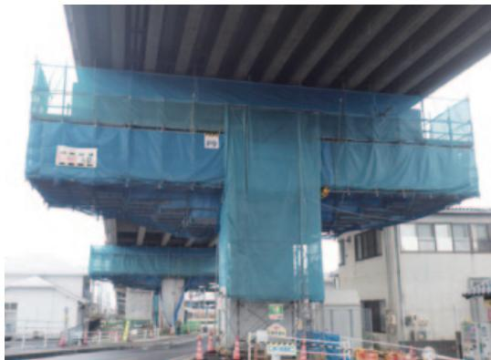
嫁島高架橋は、島根県松江市のJR松江駅の南側3kmほどの所にあり、日本夕日百選に選ばれた宍道湖の『嫁ヶ島』が目前にあります。本橋は、JR線を跨ぐ跨線橋として昭和56年に建設された橋長320m(14径間)のプレストレストコンクリート橋です。
