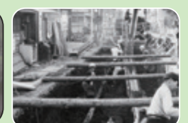
1960年の工事(施工:東急建設)
