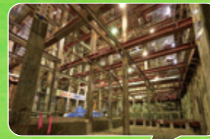
2011～2022 渋谷駅東口基盤整備工事
