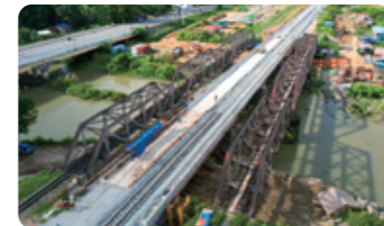
ヤンゴンーマンダレー鉄道整備工事 (CP103)
