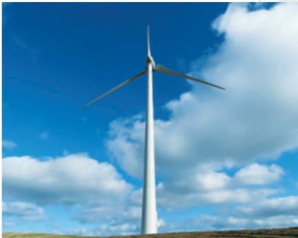
▲ 大峯山風力発電所 建設工事
