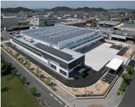
▲ (株)梶原鉄工所 新工場 新築工事
