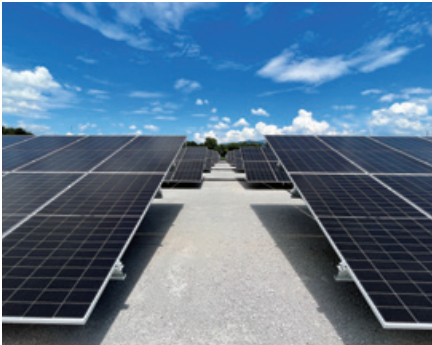
▲ 三和シャッター工業九州工場 自家消費型太陽光発電所建設工事
