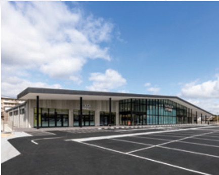
▲ ヤマダストアー青山店 改築工事
