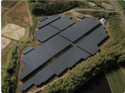
▲ 大岩田太陽光発電所 建設工事
