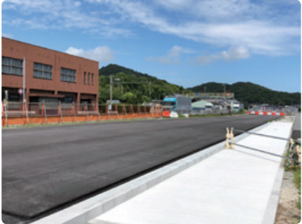
▲ 相生有年道路若狹野東地区 改良工事
