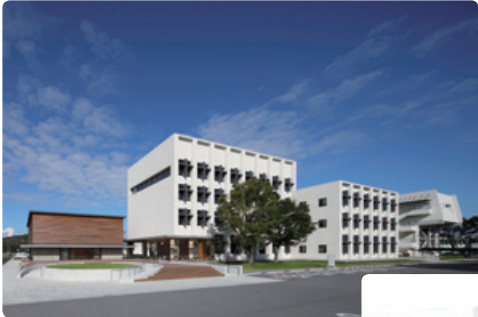
▲ たつの市本庁舎 建設工事
