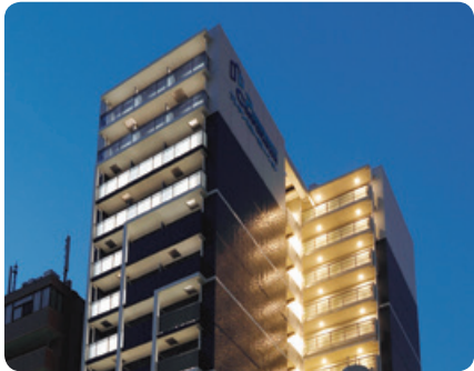
▲ プレサンス西中島一丁目 新築工事 (プレサンス新大阪ストリーム)
