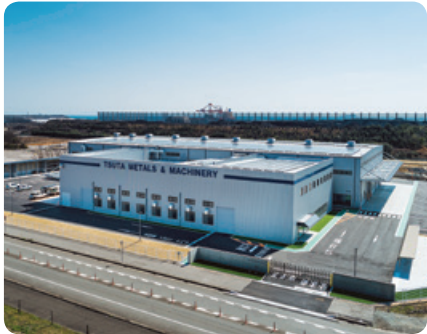
▲ 薦機械金属(株) 広畑工場 I 期工事
