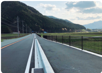
▲ 国道175号稲畑地区 歩道整備工事
