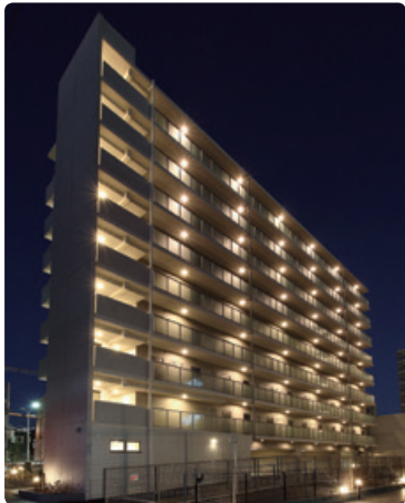
▲ 豊中市小曽根5丁目ワンルーム 新築工事 (エスプレイス江坂レジデンス)
