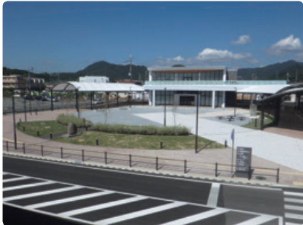
▲ 福崎駅周辺整備（その2） 工事
