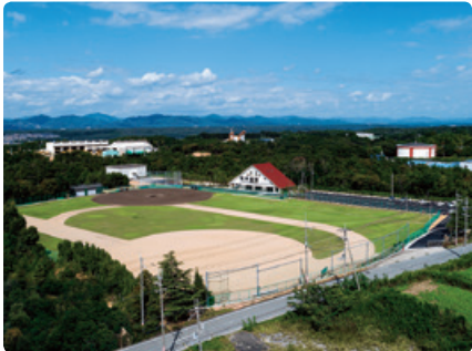
▲ 小野グラウンドクラブハウス 新築工事
