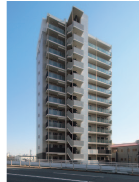
↑ エスリード大正区三軒家東2丁目 新築工事
