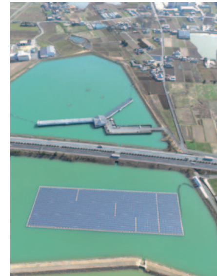
↑ 桜下池 水上太陽光発電所工事
