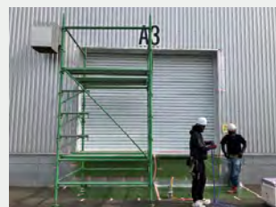
外構シャッターへの遮熱塗装の様子
