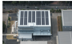
一貫生産棟の屋根に設置
