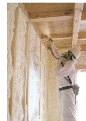
当社を支えるアクアフォームは、温室効果の大きいフロンガスを使わず、水を使って現場で発泡させる断熱材です。水を含むポリオールとイソシアネートを混合することで発生する炭酸ガスを発泡剤として使用する、人と地球に優しい硬質ウレタンフォーム素材となっております。
